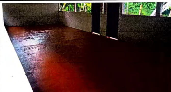
Foto 4: Piso de aulas finalizado.
