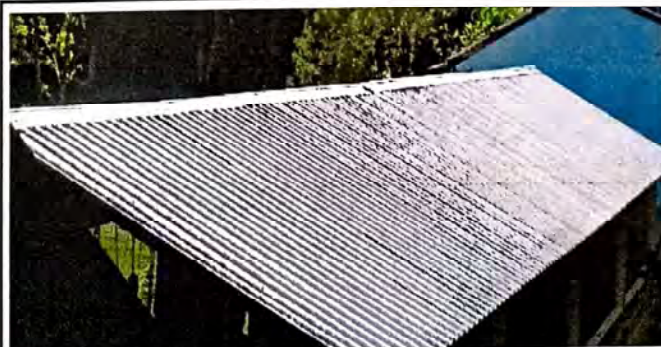
Foto 2: Entechado de aulas modulo 3 finalizado.
