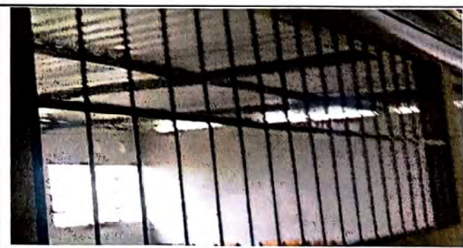
Foto 6: Instalación de ventanas finalizado.
