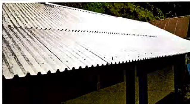
Foto 1: Sustrucción de estructura y entechado de aulas modulo 1 finalizado.
